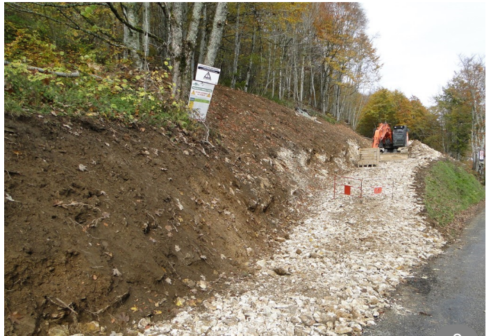
Place de dépôt (chargeoir) des Combes : de l'abattage du bois d'emprise à l'empierrement en passant par le terrassement
