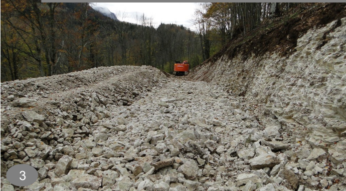
Place de dépôt (chargeoir) des Combes : de l'abattage du bois d'emprise à l'empierrement en passant par le terrassement
