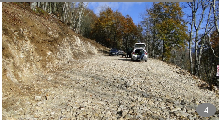
Place de dépôt (chargeoir) des Combes : de l'abattage du bois d'emprise à l'empierrement en passant par le terrassement
